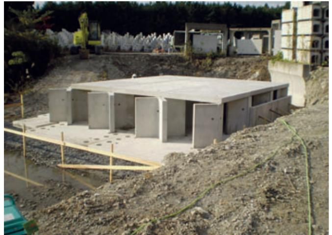
Abbildungen 5 und 6: Montage des X-förmigen Regenwasserspeichers
