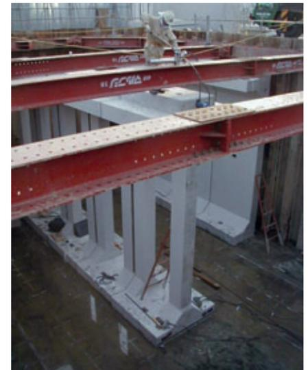
Abb. 4 zeigt die Verbindungsmethode auf der Baustelle. Die I-förmigen Elemente werden mittels Vorspanntechnik verbunden, um die Erdbebensicherheit zu gewährleisten.
